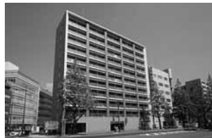
H25年2月完成 鉄筋11階 全100室 宮城県仙台市青葉区本町1 契約年数1年 更新料新家賃の0.5ヶ月分
