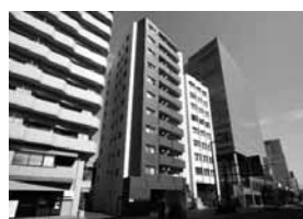
H20年12月完成 鉄筋コンクリート造11階 全60室 宮城県仙台市青葉区花京院2丁目1-6 契約年数 1年 更新料:新家賃の0.5ヶ月分
